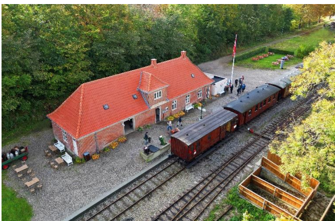
Handest Station med nyt tag. Perronen er med støtte fra Vindpark Handest Hede
