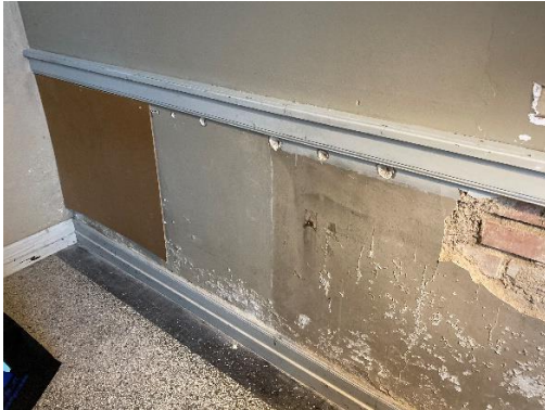
Nedslidt ventesal med velholdt terrazzogulv
