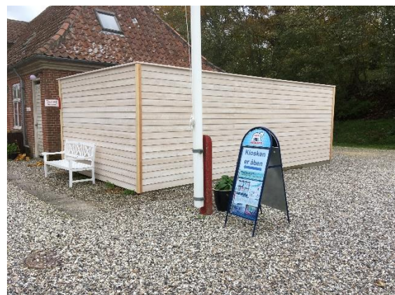
Køkkengård og brændeskur nyopført
