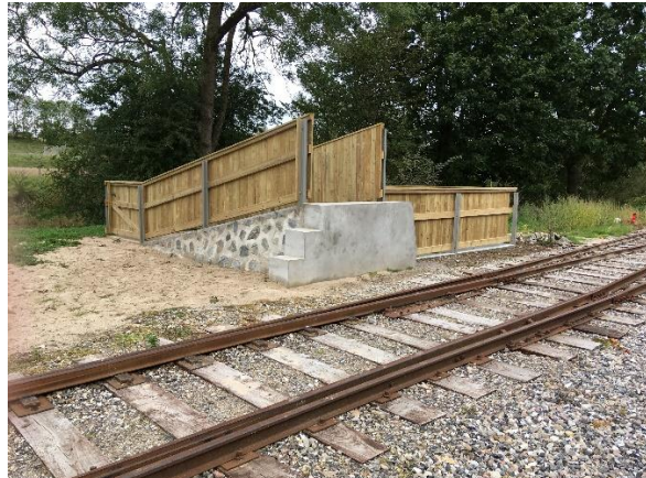
Totalrenoveret kvægfold og rampe med støtte fra Vindpark Handest Hede
